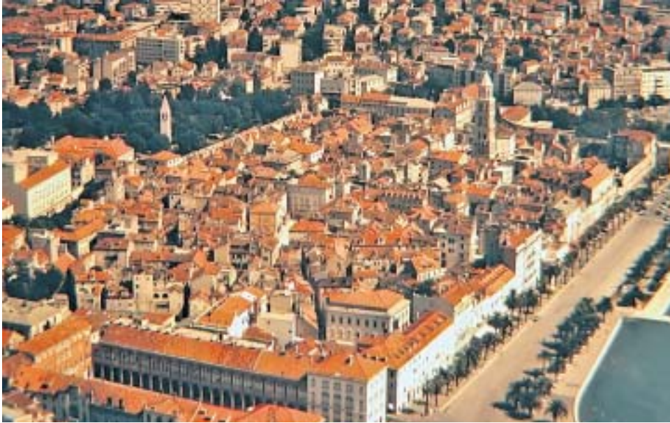
Osim kroz svodove, vlaga koja nagrizala palaču prodire i kroz temelje i kroz zidove
