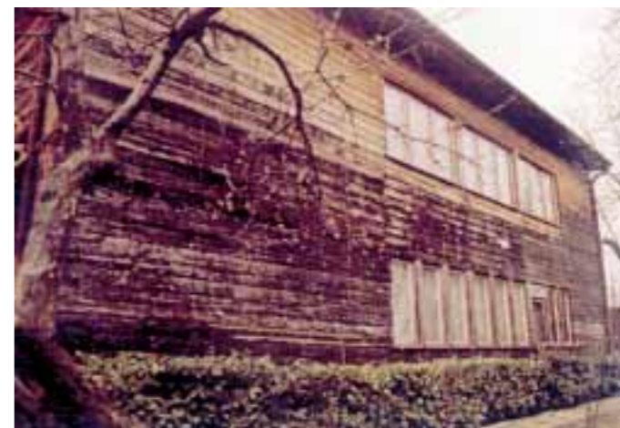
Remek djelo: Hrvatska je još 1938. zahvaljujući Ibleru imala »drvenu montažnu kuću«!
